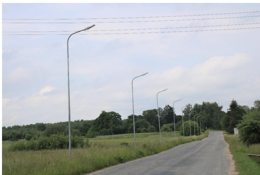
6. att. Veikta ielu apgaismojuma izbūve Paplakas ciema centrā
