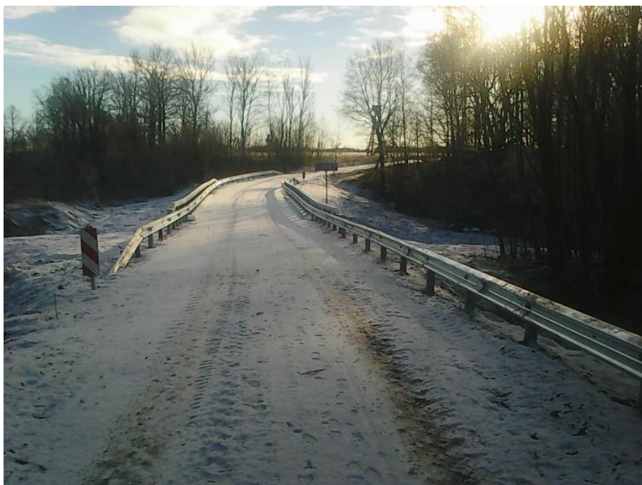
12. att. Jauns tilts slēgtā Daļģu tilta vietā
