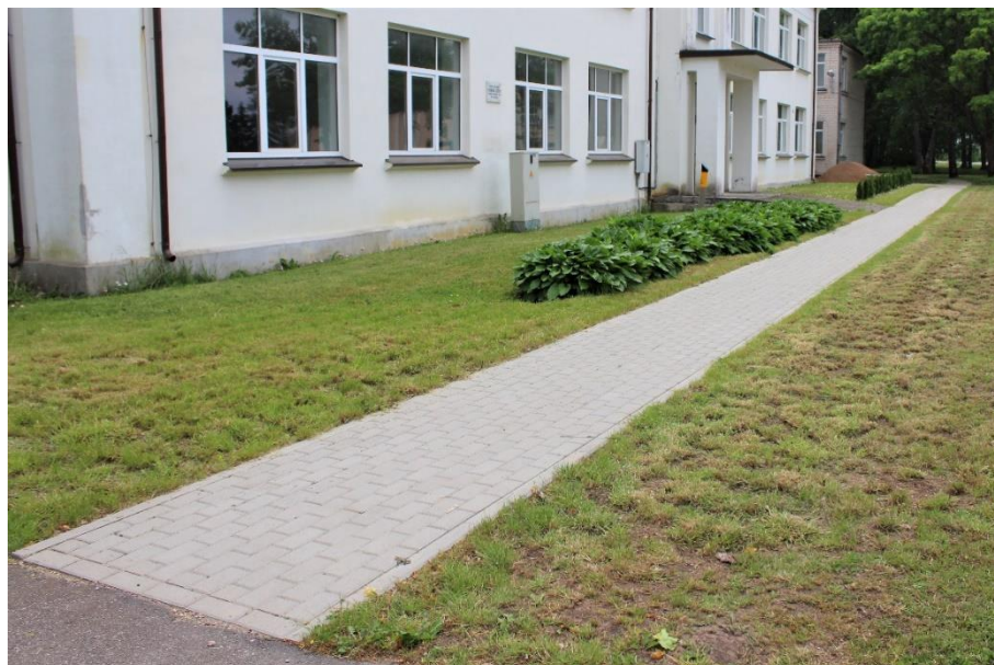
5. att. Gājēju ceļa izbūve pie ēkas Skolas ielā 4
