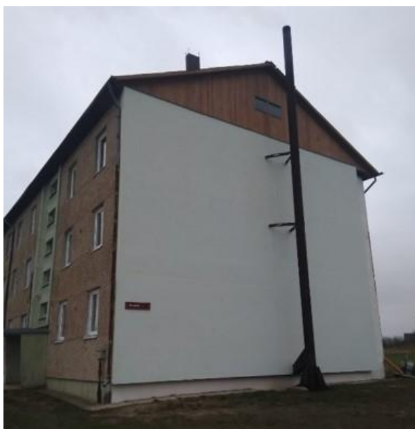
3. att. Gala sienas siltināšana un skursteņa remonts Krasta ielā 3
