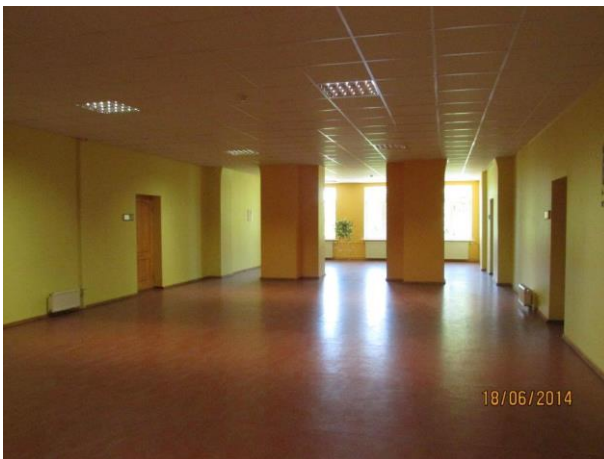
Priekules vidusskolas 2.stāva vestibils pēc remonta
